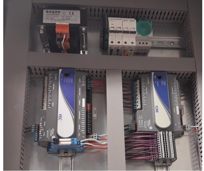
Görsel 1: Pano İçerisi Mikroişlemciler
