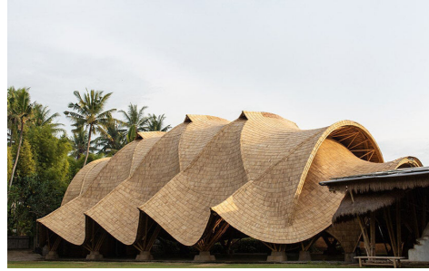
Foto 2. Endonezya/ Bali'deki Green School kampüsünde bir okul binası (tasarımın ana malzemesi bambu ağacıdır).
