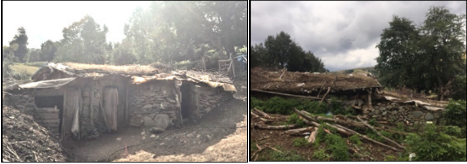
Foto 3-4. Aşağı Çukuralan Yaylası'nda terk edilmiş bir meskenin iki farklı cepheden görünümü
