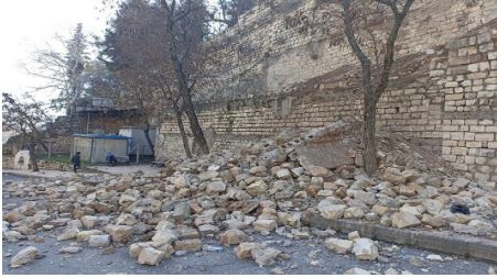
Görsel 13. Kahramanmaraş Kalesinin Durumu
