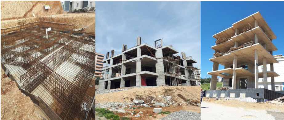
Görsel 1. Deprem Yönetmeliğine Uygun Olarak Yeni İnşa Edilen Betonarme Yapının Genel Görünümü
