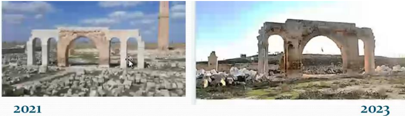
Şekil 2. Mimari Mirasımıza Örnek, Harran. Restorasyon yapımı 2021, 6.Şubat.2023 Depremi sonrası 2023.
