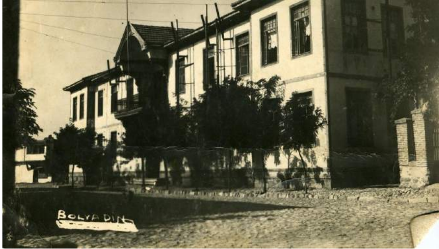
Bolvadin eski hükümet konağı 1926
