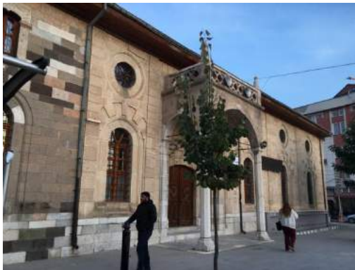
Resim 5. Çarşı Camisi kuzey cephesi (2017)
