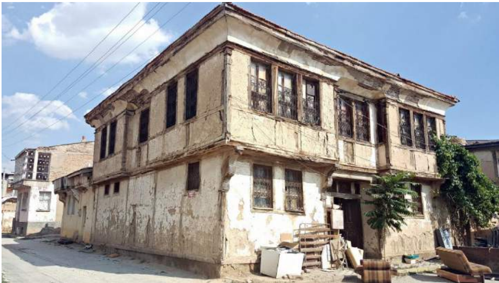
Resim 9. 280 Ada 17 Parseldeki Evin bugünkü durumu
