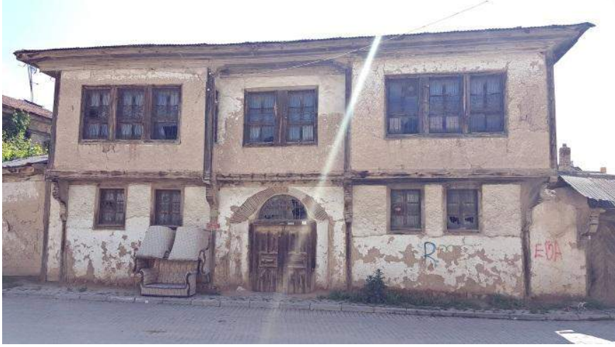
Resim 7. 280 Ada 14-15 Parseldeki Evin bugünkü durumu
