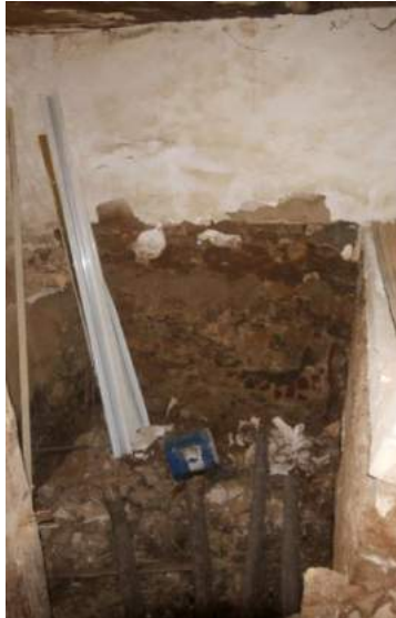
Foto. 34. Zeminin Tař Duvarı
