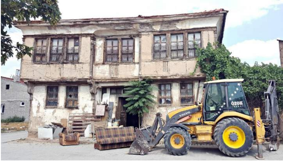
Resim 8. 280 Ada 17 Parseldeki Evin bugünkü durumu
