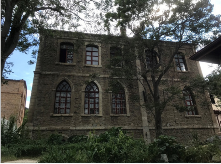
Şekil 29. Akşehir Ermeni Mektebi Kuzeybatı Cephesi Görünümü (Yağcı, 2020)
