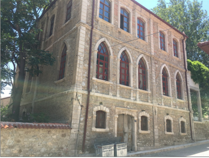
Şekil 26. Akşehir Ermeni Mektebi Kuzeybatı Cephesi Görünümü (Yağcı, 2020)
