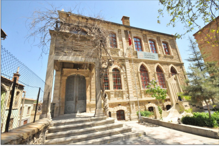
Şekil 23. Akşehir Ermeni Mektebi Güneybatı Cephesi Görünümü (Yağcı, 2020)
