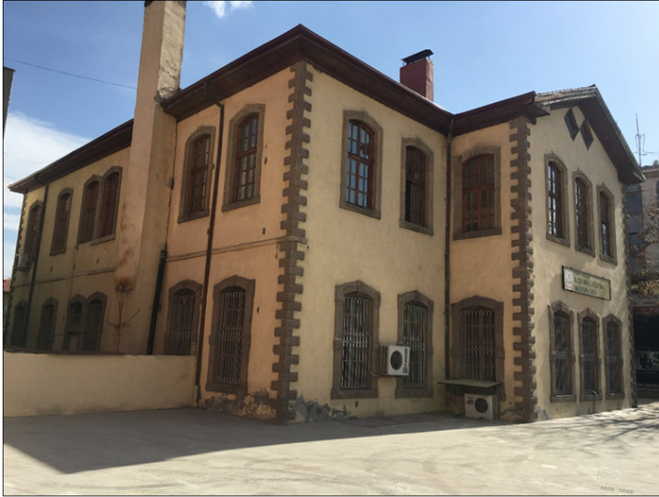
Şekil 40. Fransız Erkek Mektebi Kuzeydoğu Cephesi Görünümü (Yağcı, 2020)
