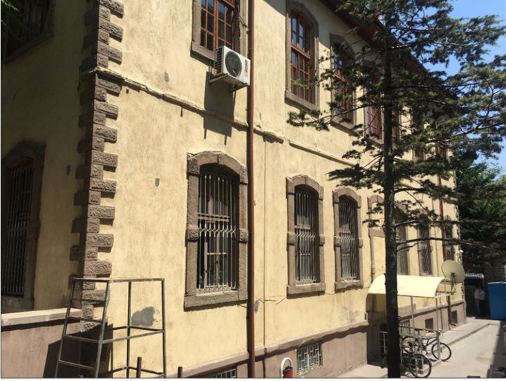
Şekil 38. Fransız Erkek Mektebi Güneybatı Cephesi Görünümü (Yağcı, 2020)
