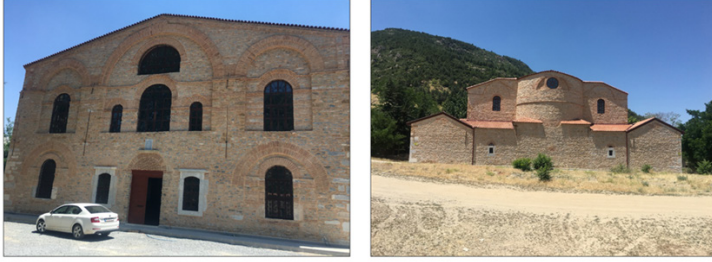
Şekil 18. Akşehir Ermeni Kilisesi Giriş Cephesi (Solda) ve Arka Cephe (Sağda) (Yağcı, 2020)
