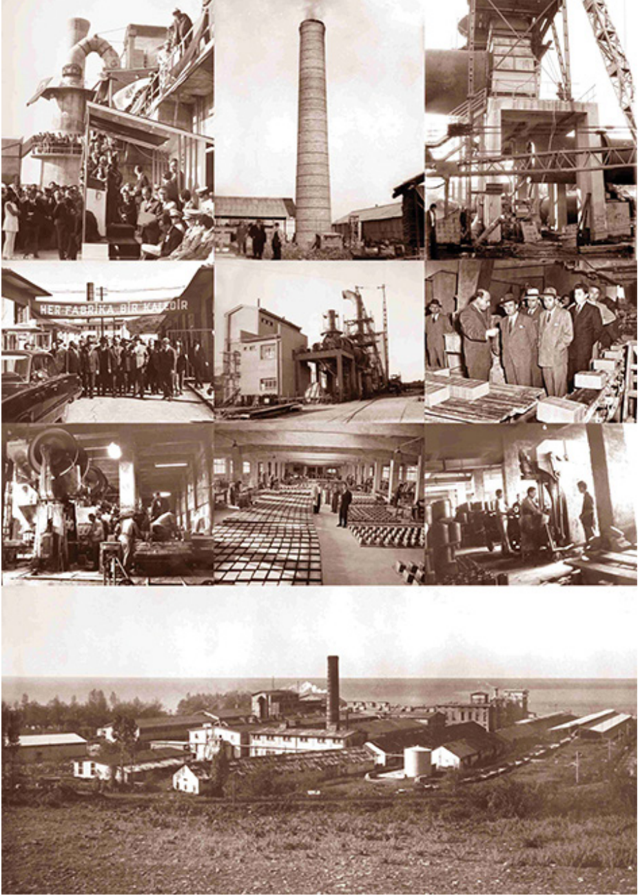
Şekil 27. Filyos Ateş Tuğla Üretim tesisi temel ama ve açılış (Filyos Ateş Tuğla, 2024)
