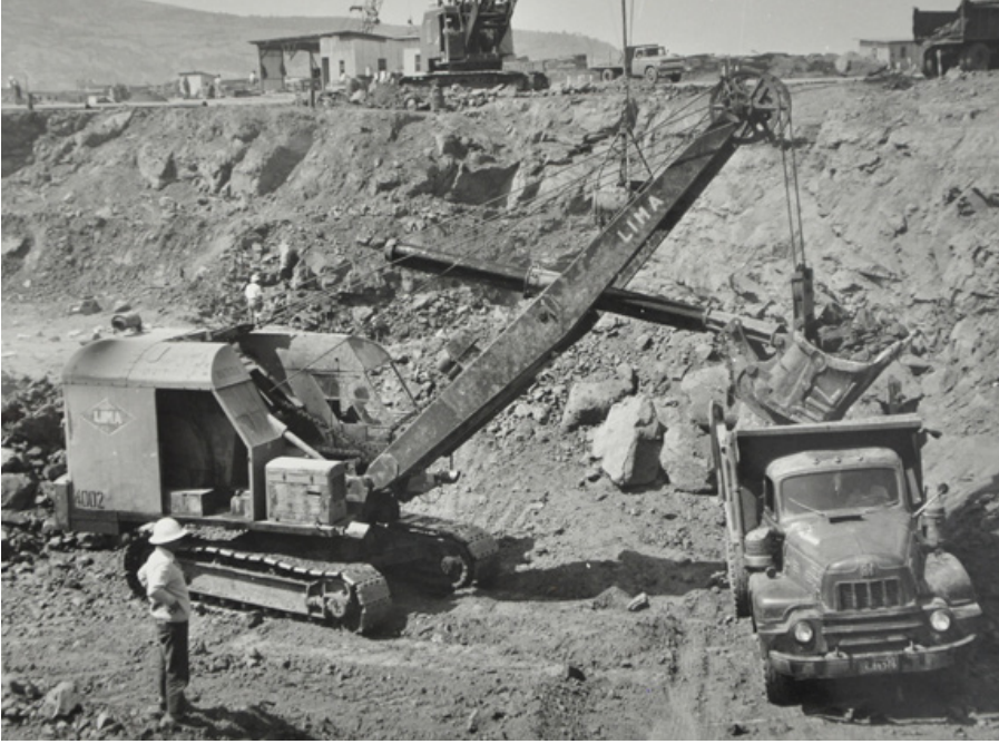
Şekil 8. Ereğli demir çelik tesisi inşaatı (Erdemir, 2023)
