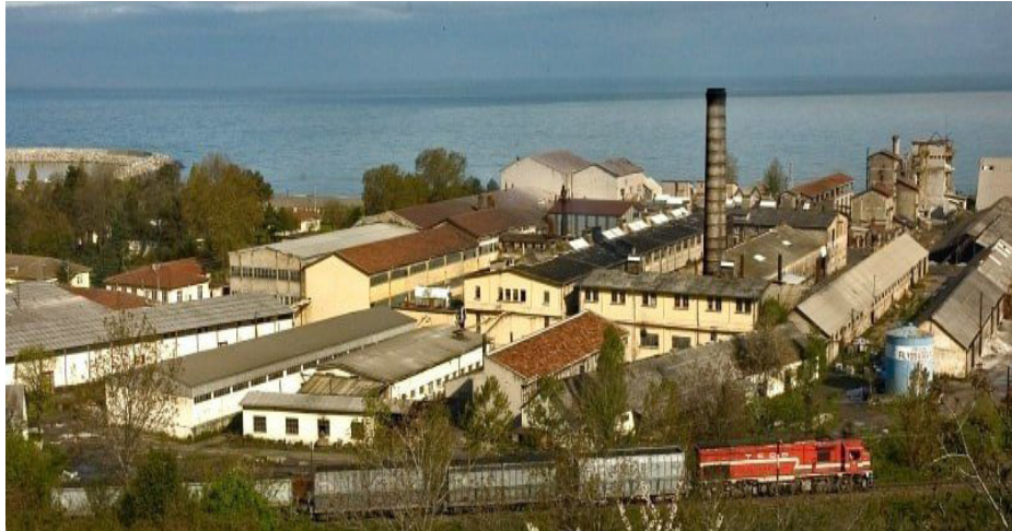
Şekil 26. Filyos Ateş Tuğla Üretim Tesisi (İnanış, 2023)
