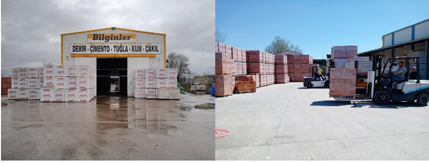
Şekil 43-44. Bilginler Hazır Beton ve Tuğla üretim tesisi
