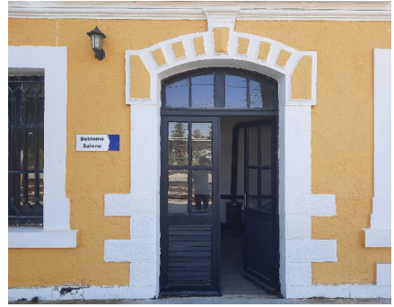
Peron cephesinde Bekleme Salonu'nun girişi
