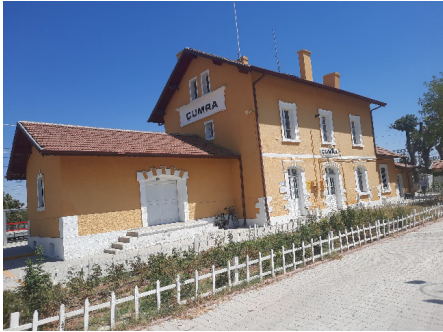
Güneybatıdan görünüm (ön ve sol yan cephe)
