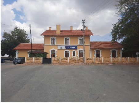
Ön cephe (güney cephe)
