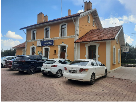
Ön cephe (kuzey cephe)
