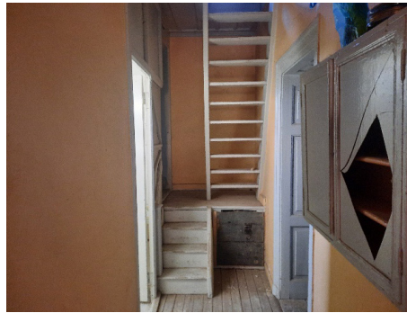
1. katta wc ve çatıya çıkış merdiveni
