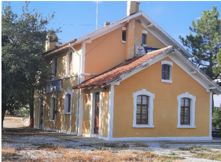
Güneybatıdan görünüm (giriş ve sağ yan cephe)
