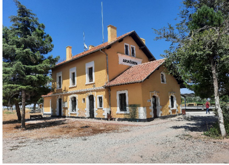
Giriş ve sağ yan cephe (kuzey cephe)
