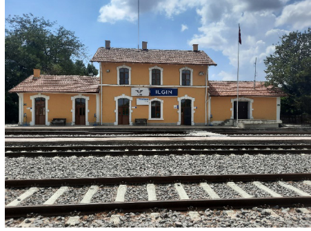
Peron cephesi (kuzey cephe)
