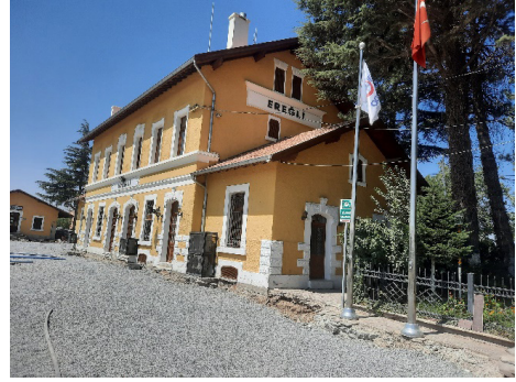
Doğudan görünüm (peron ve sol yan cephe)
