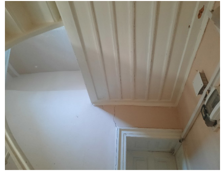
Üst kat tavanlarında çitallı kaplama
