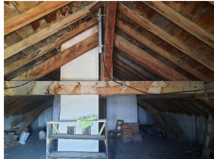
Kaşınhan Tren İstasyonu orta bölümünün asma çatısı
