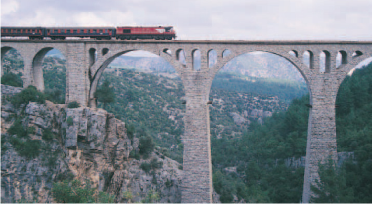
Şekil 9. Toros dağları Hacıkırı mevkiindeki Varda Köprüsü (Hicaz Demiryolu Fotoğraf Albümü, 1999: 103)
