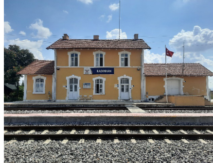
Peron cephesi (kuzey cephe)
