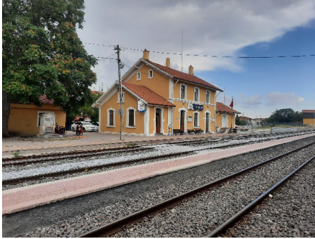
Güneydoğudan görünüm (Sağ yan ve peron cephesi)
