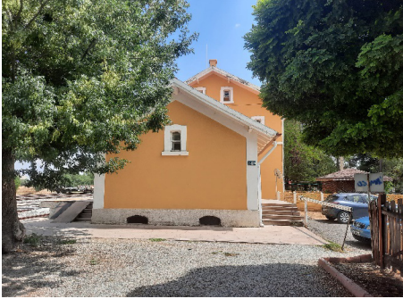
Sol yan cephe (batı cephe)
