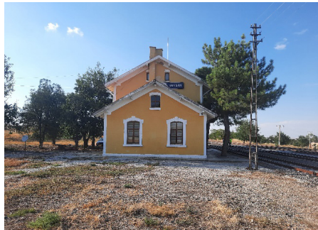
Sağ yan cephe (güney cephe)
