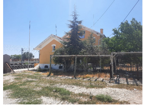
Sol yan cephe (kuzey cephe)
