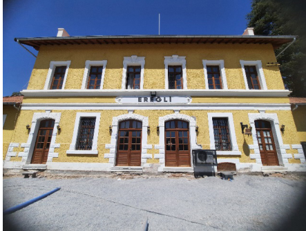
Peron cephesi (güneydoğu cephe)
