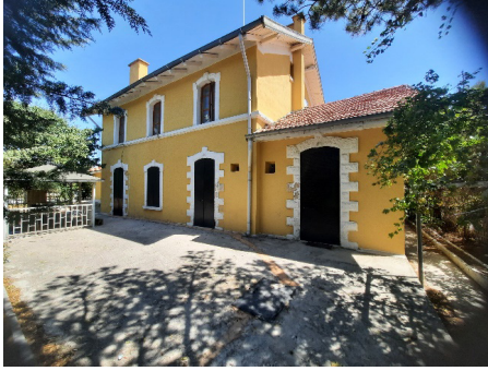
Ön cephe (batı cephe)
