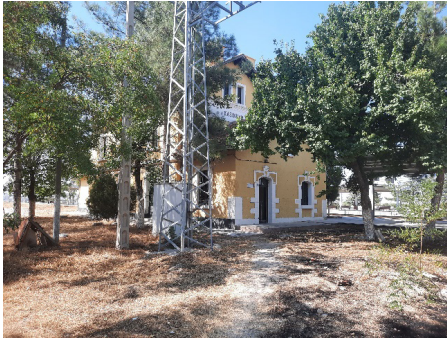
Güneyden görünüm (sağ yan cephe)
