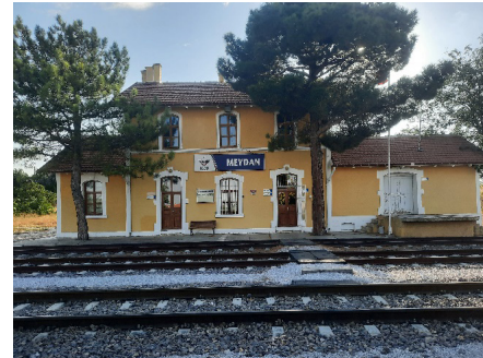
Peron cephesi (doğu cephe)
