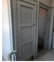
Wc girişi ve çatı çıkışı
