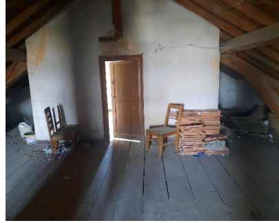
Çatı arası boşluğu
