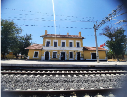
Peron cephesi (kuzeydoğu cephe)
