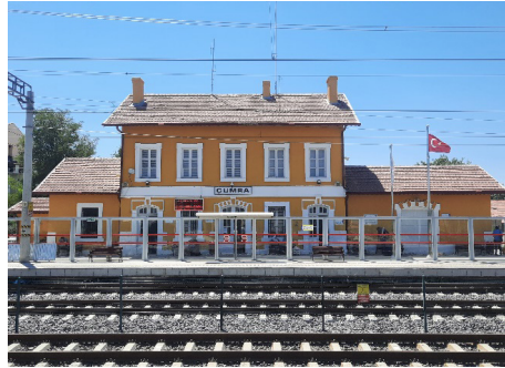
Peron cephesi (kuzeydoğu cephe)
