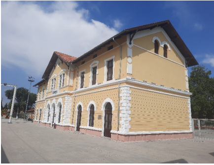
Peron ve sağ yan cephe (güneybatı cephe)
