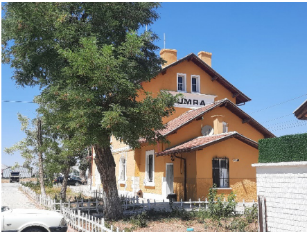
Sağ yan ve giriş cephesi
