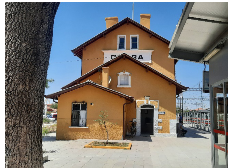
Sağ yan cephe (güneydoğudan görünüm)
