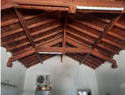
Çumra Tren İstasyonu ambar bölümünün asma çatısı
