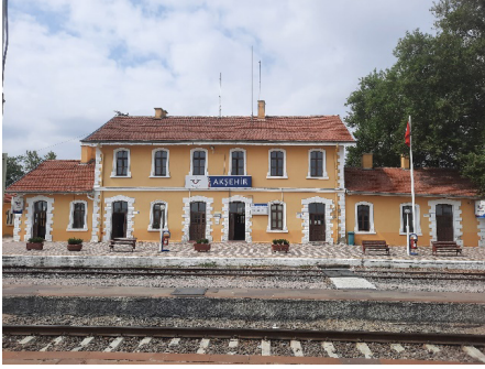
Peron cephesi (kuzeydoğu cephe)
