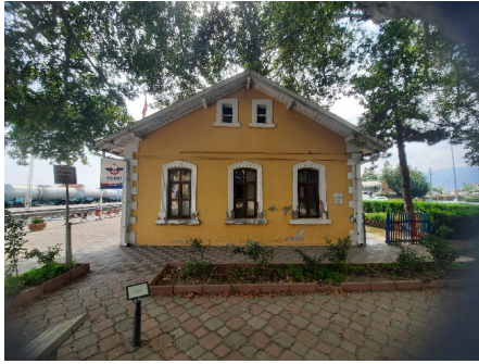
Sol yan cephe (kuzeybatı cephe)
