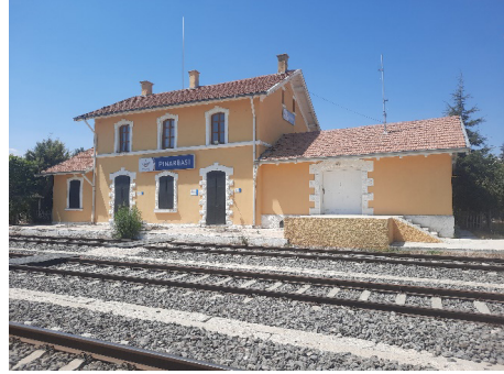
Peron cephesi (doğu cephe)
