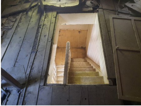
Çatıya çıkış merdiveninin çatıdan görünümü
