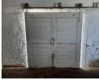
Ambarda sürme kapı sistemi
