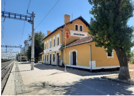
Peron ve sol yan cephe (güneyden görünüm)
