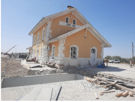
Doğudan görünüm (peron ve sol yan cephe)
