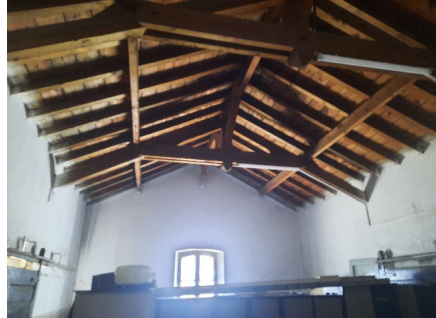
Kaşınhan Tren İstasyonu ambar bölümünün asma çatısı
