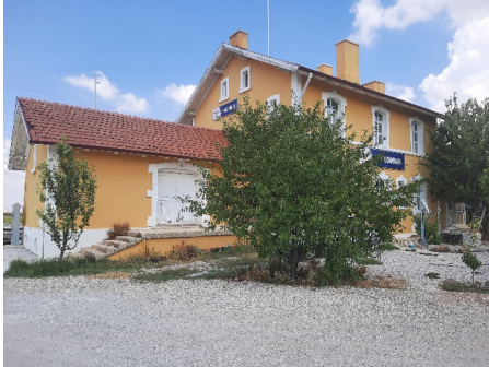
Ön cephe (güney cephe)
