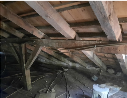
Akşehir Tren İstasyonu'nun orta bölümünün oturtma çatısı
